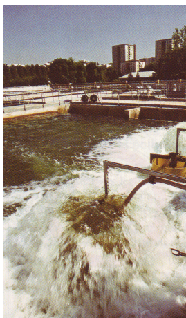
Captage de l'eau
