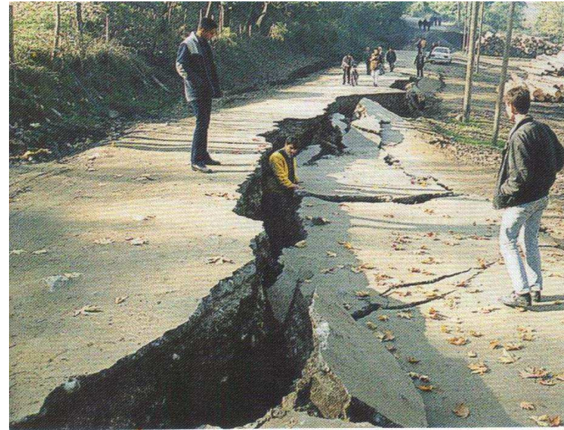
C. Déformation apparue lors du séisme de Duzce (nord de la Turquie) en 1999. Une faille* de 35 km de long est apparue en surface. La plupart des routes ont été endommagées autour de Duzce.
