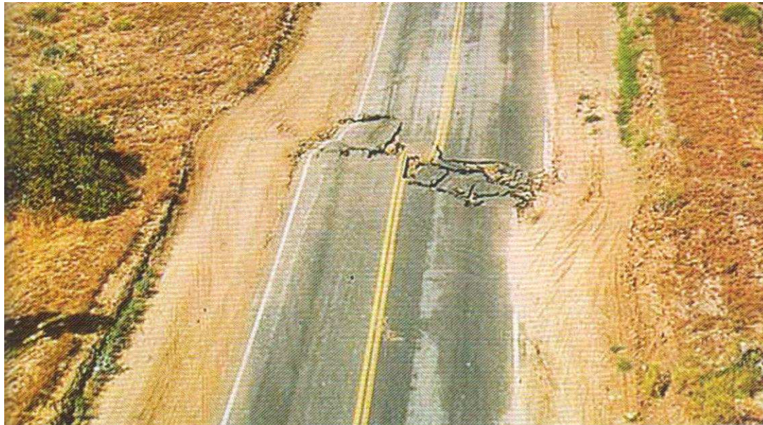
C. Déformation apparue lors du séisme de Duzce (nord de la Turquie) en 1999. Une faille* de 35 km de long est apparue en surface. La plupart des routes ont été endommagées autour de Duzce.
